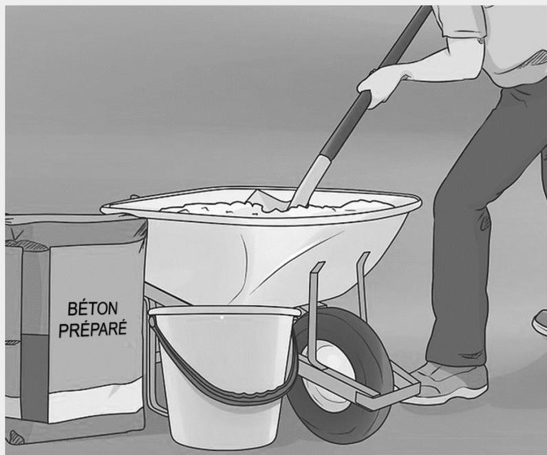
Préparez un mortier de béton peu liquide qui servira à remplir les piliers. Voici le dosage recommandé : mélangez 1 volume de ciment avec 1 volume de sable et 2 volumes de gravier. Pour mélanger le béton à la main, versez la quantité nécessaire de sable et de ciment sur une sous-couche propre ou dans une brouette. Ensuite, mélangez soigneusement le tout à l'aide d'une pelle.
