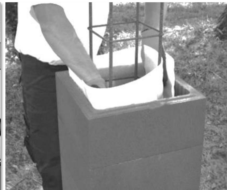
Appliquez le film de mousse polyéthylène sur le pourtour des parois intérieures du pilier, en commençant par la base et en remontant vers le haut. Ce film servira à prévenir d'éventuelles microfissures. Évitez de remplir les piliers lorsque la température dépasse 30°C et la température inférieure à 5°C. Ces extrêmes thermiques peuvent compromettre la qualité du béton et entraîner des problèmes structurels.
