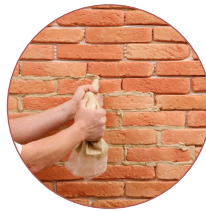
2 Je réalise les joints
