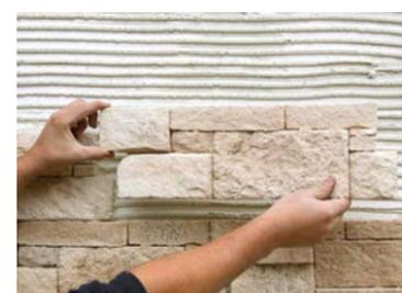
**1.** Collez les parements en double encollage en laissant un joint de 2 mm.
