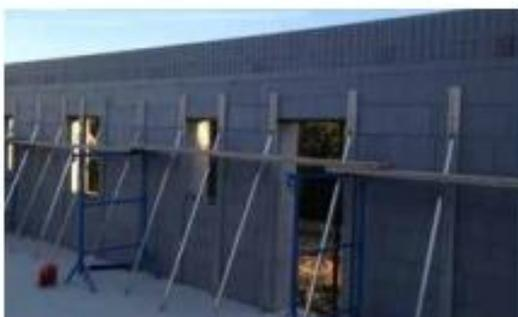
5) Fixation de la platine de la jambe de force vis acier  $\varnothing 7,5$  mm, longueur 70 mm. Ces vis sont fournies par quick'up et permettent une fixation sans chevilles.
