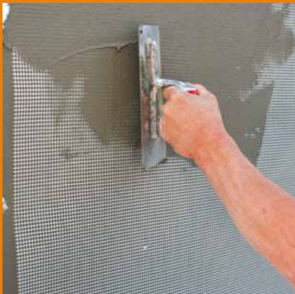
ARMATURE POUR SYSTÈME ITE PRB THERMOLOOK EMI
