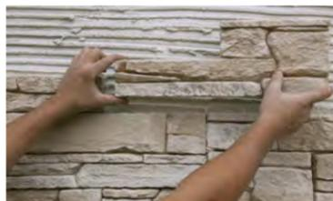
1. Posez les plaques une à une en procédant à un double encollage avec le Mortier Colle ORFLEX et un peigne 9 x 9 x 9.
