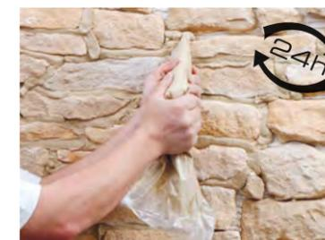
2. Jointoyez les parements 24 h après la pose avec le mortier joint ORSOL que vous déposerez dans les joints à l'aide d'une poche à joint ORSOL.
