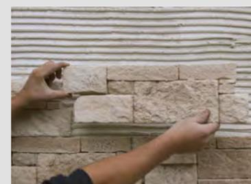
1. Posez les parements bords à bords en double encollage avec le Mortier Colle ORFLEX.
