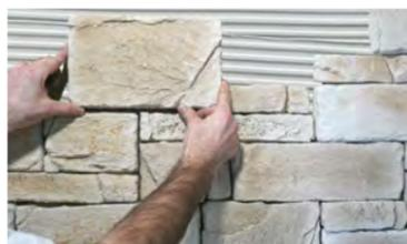
1. Posez les pierres bord à bord en procédant à un double encollage avec le Mortier Colle ORFLEX.
