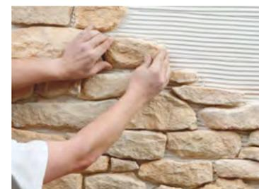
1. Posez les parements en double encollage avec le Mortier Colle ORFLEX en laissant un joint de 1 à 2 cm entre chaque pierre.
