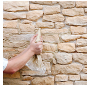
2 - Je réalise les joints
